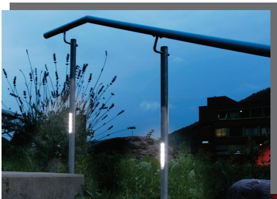
Treppenbeleuchtung Staircase lighting
